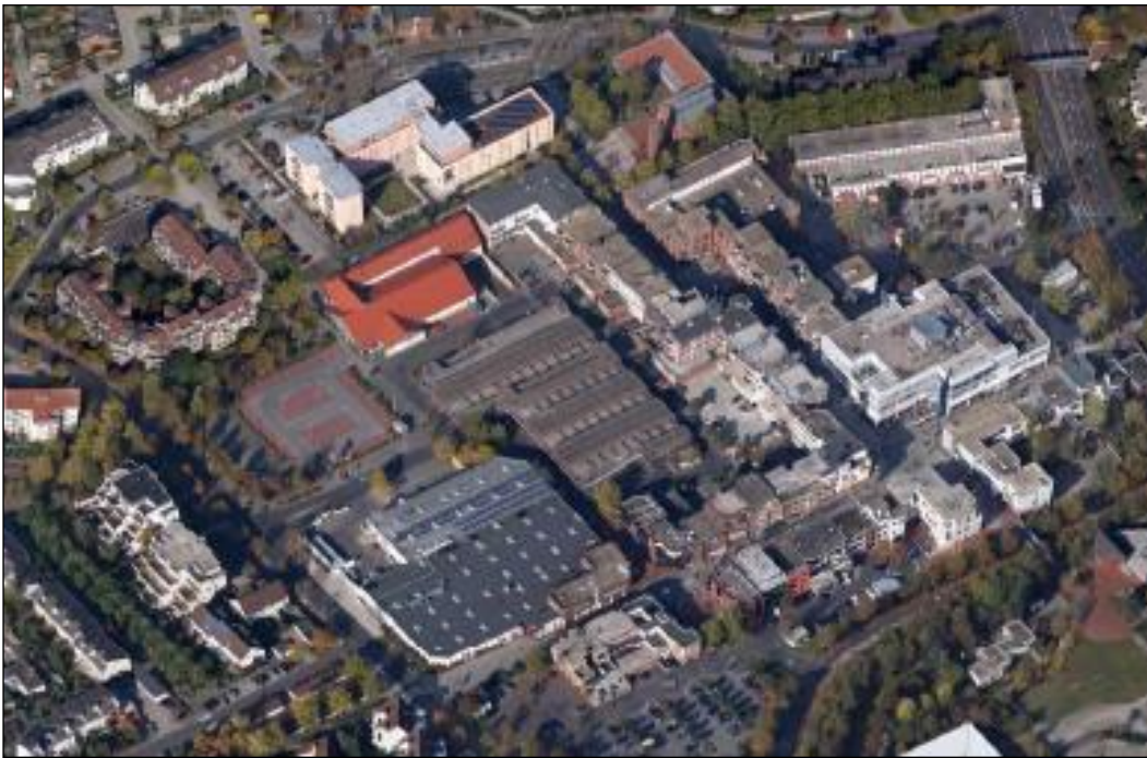
Bild 4-26 Meckenheim, Luftbild des Baubereichs „Neuer Markt“ (Quelle: Google Maps)
