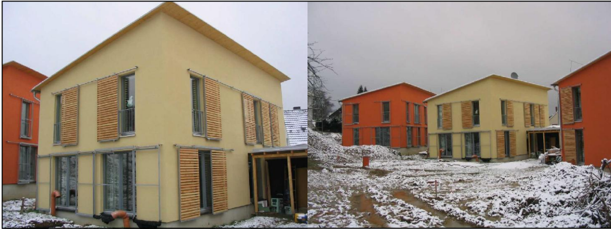
Bild 4 Passivhäuser „St. Gereon Hof“ in Wachtberg-Niederbachem, Dezember 2004 (Quelle: www.st-gereons-hof.de/doku )
